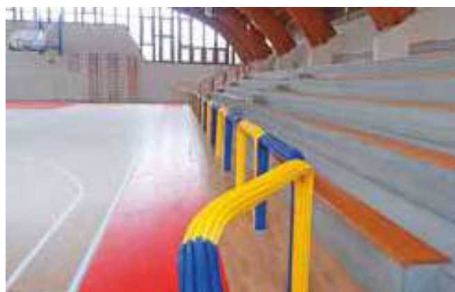
Tipologia di transenna con forma ad U rovesciata e protezioni - Barrier with upside down "U" shape and protection pads.
