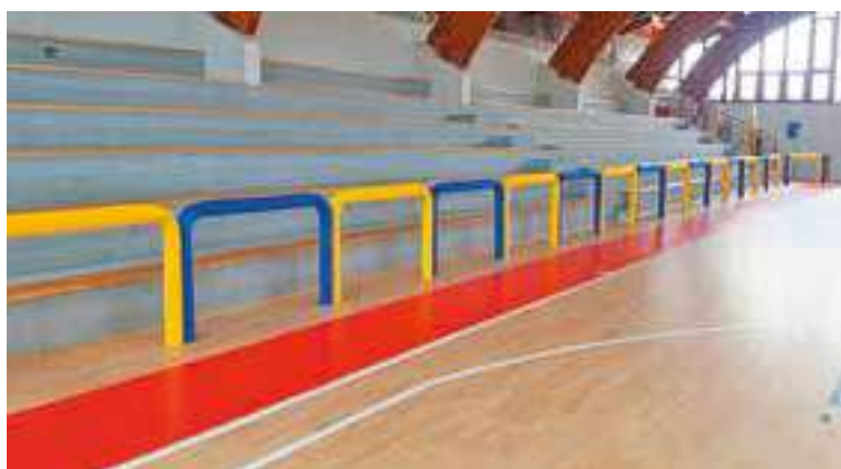
Tipologia di transenna con forma ad U rovesciata e protezioni - Barrier with upside down "U" shape and protection pads.
